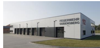
Stützpunkt FF Gudensberg Fertigstellung: 2018 Kosten 5.500 T EUR (Quelle HNA)
