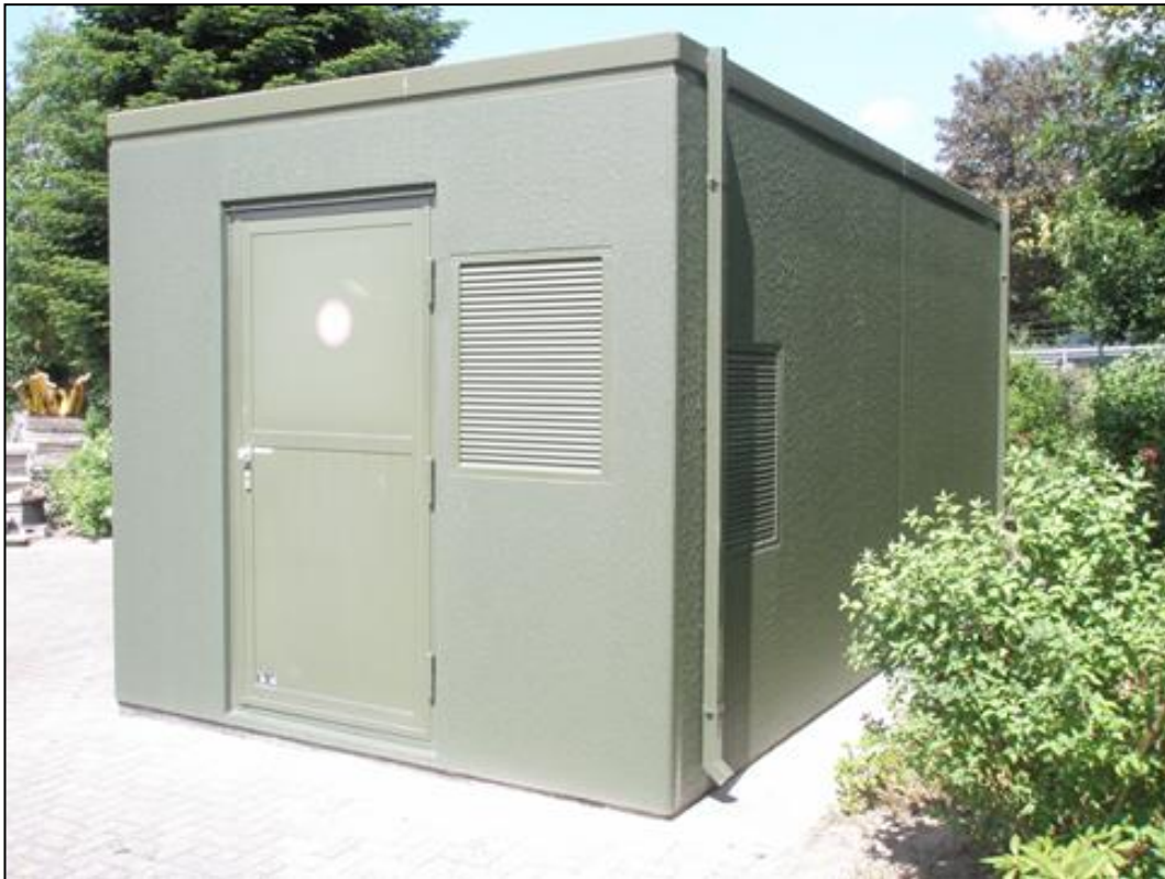
Abbildung 3: Beispiel Außenansicht eines Hauptverters in Fertigbauweise (erstellt durch BBA)
