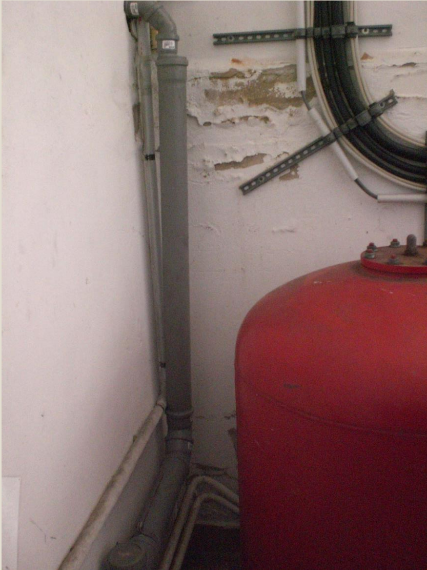
Sockelwände Technikbereich durchfeuchtet
