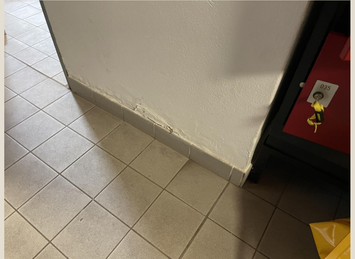
Innenwände Umkleidebereich aufsteigende Feuchtigkeit
