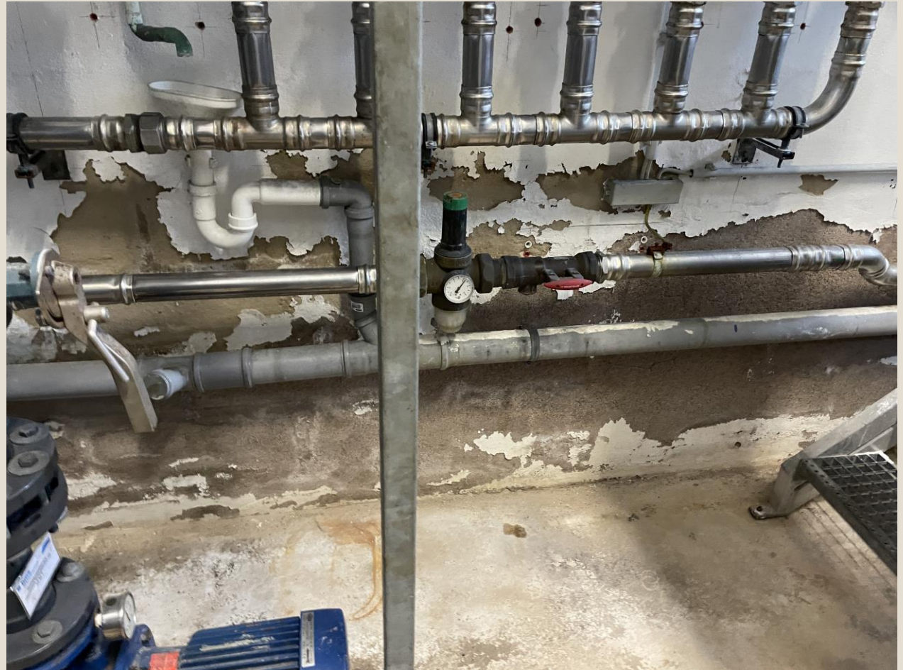
Sockelwände Technikbereich durchfeuchtet
