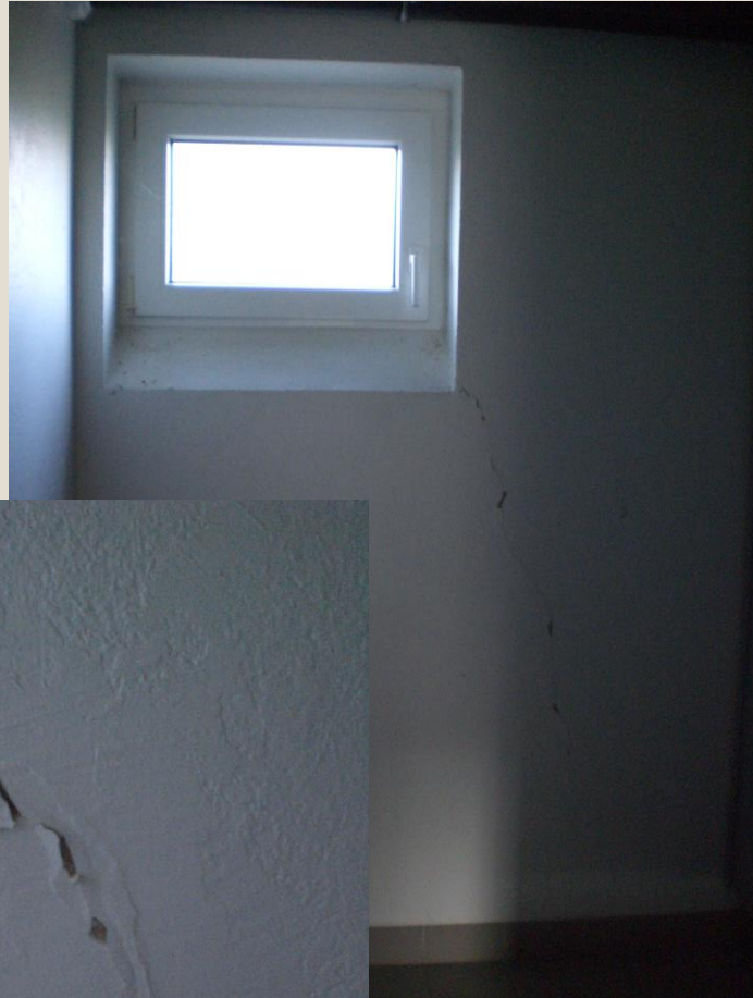
Mauerwerksriss Umkleideflur
