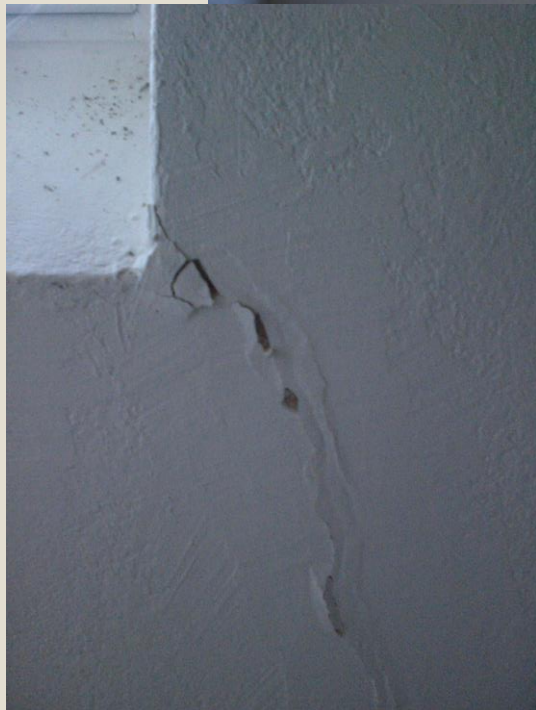
Mauerwerksriss Umkleideflur
