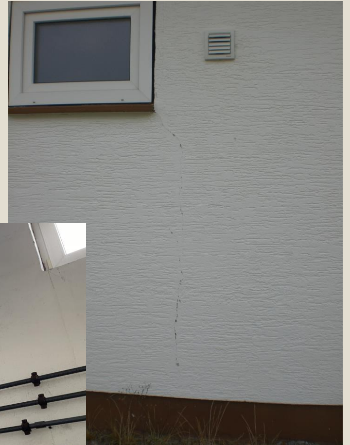
Mauerwerksriss Technikraum
