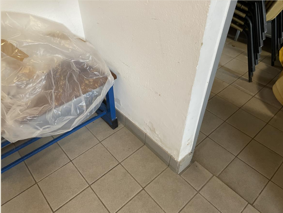
Innenwände Umkleidebereich aufsteigende Feuchtigkeit
