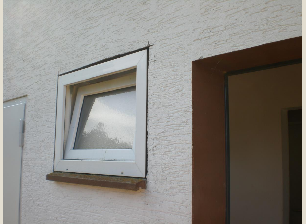
Neue Fenster mit Fugenband
