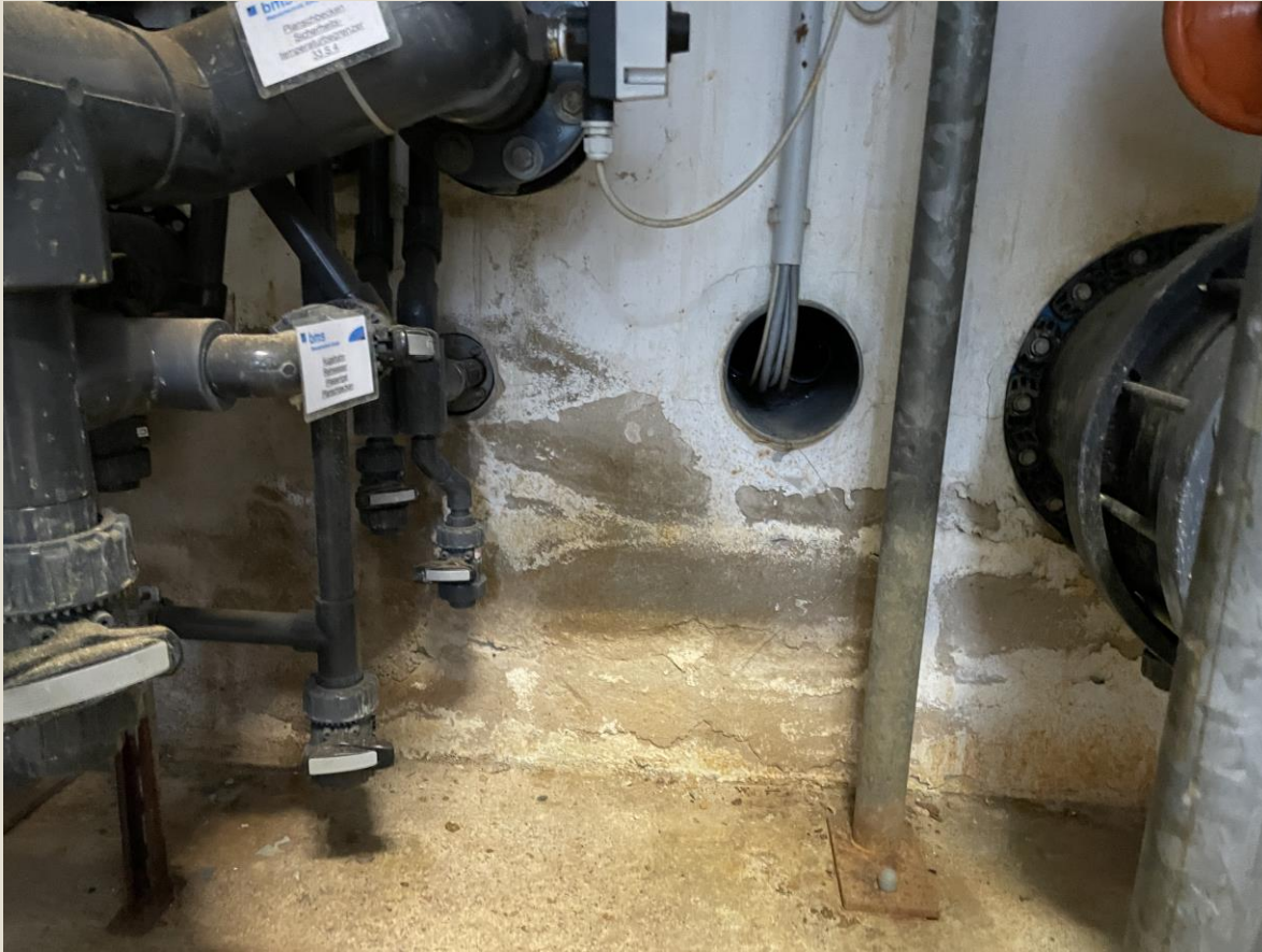
Sockelwände Technikbereich durchfeuchtet
