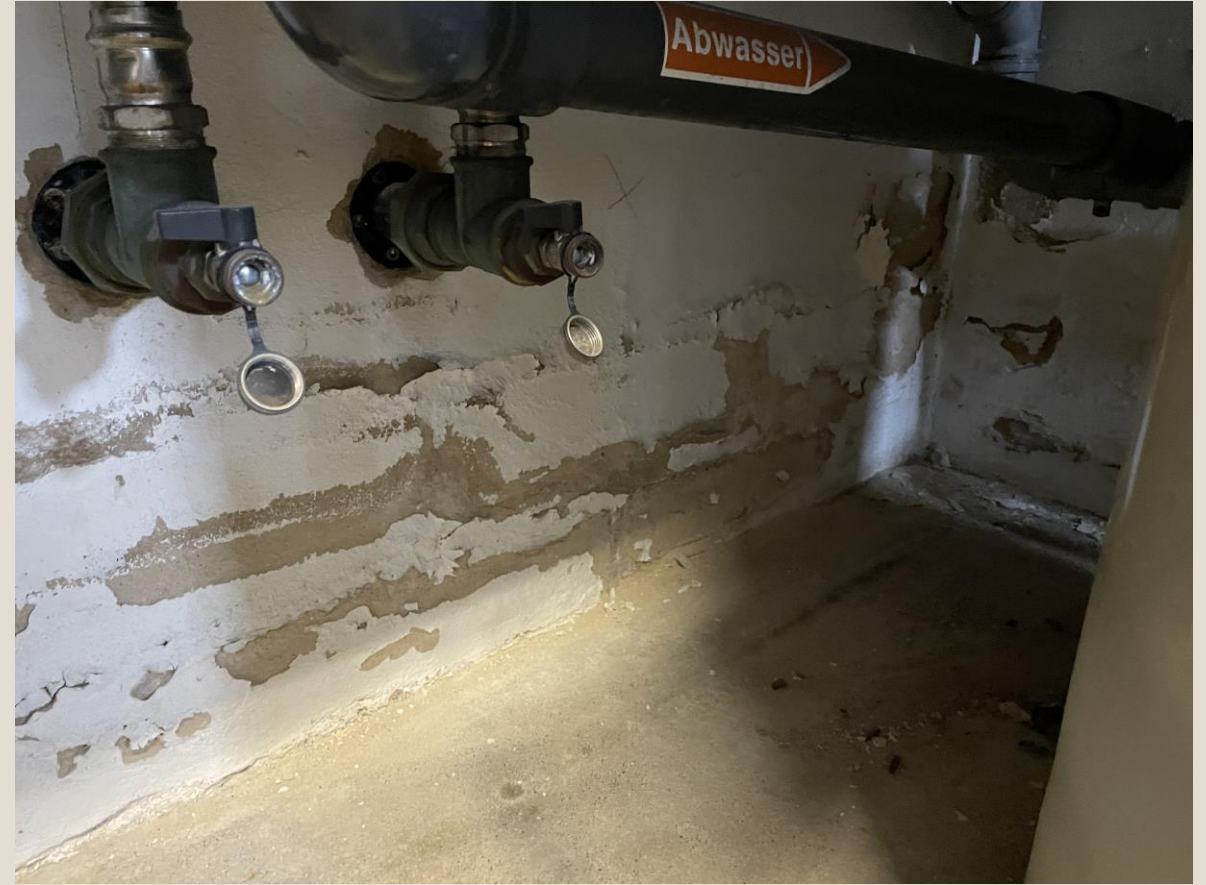
Sockelwände Technikbereich durchfeuchtet
