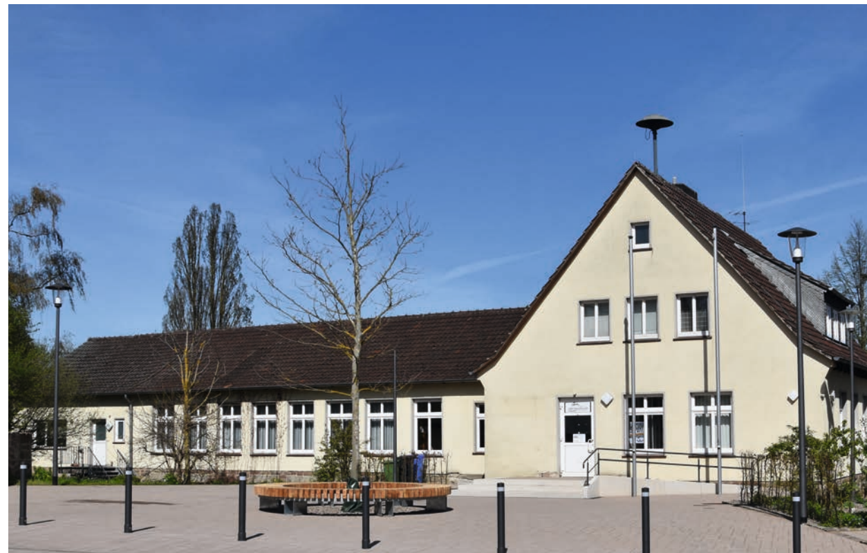
Aktuelle Westansicht Gemeinschaftshaus.
