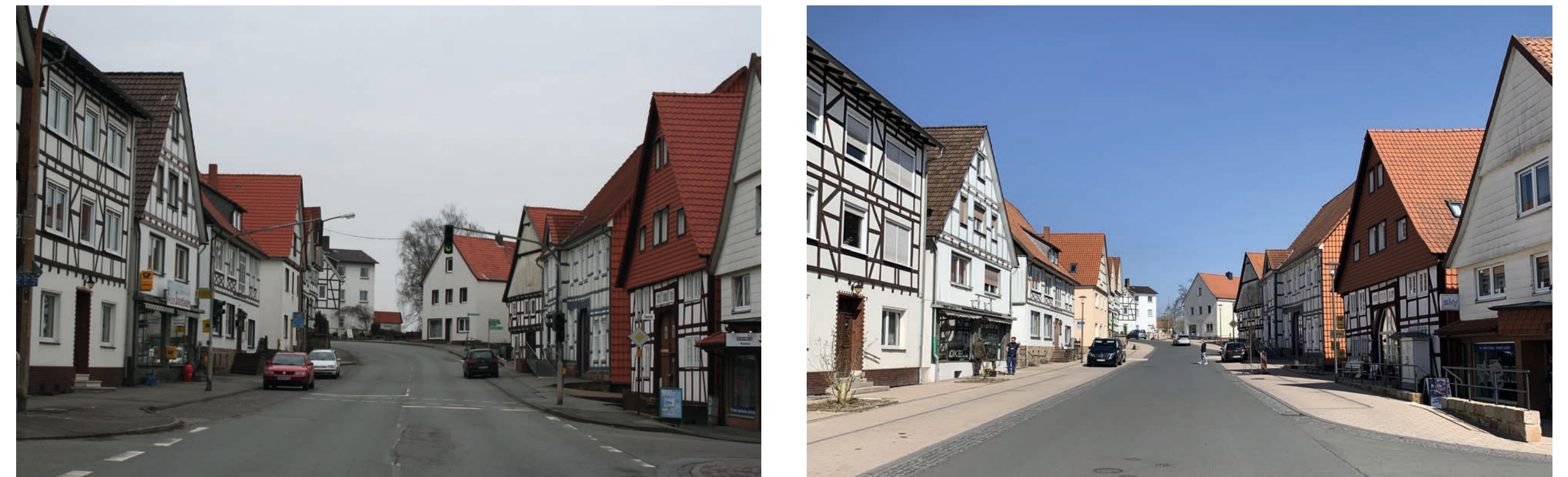
Deutliche Reduzierung des Fahrbahnquerschnitts zugunsten von öffentlichen Plätzen und privaten Gebäudevorbereichen.
