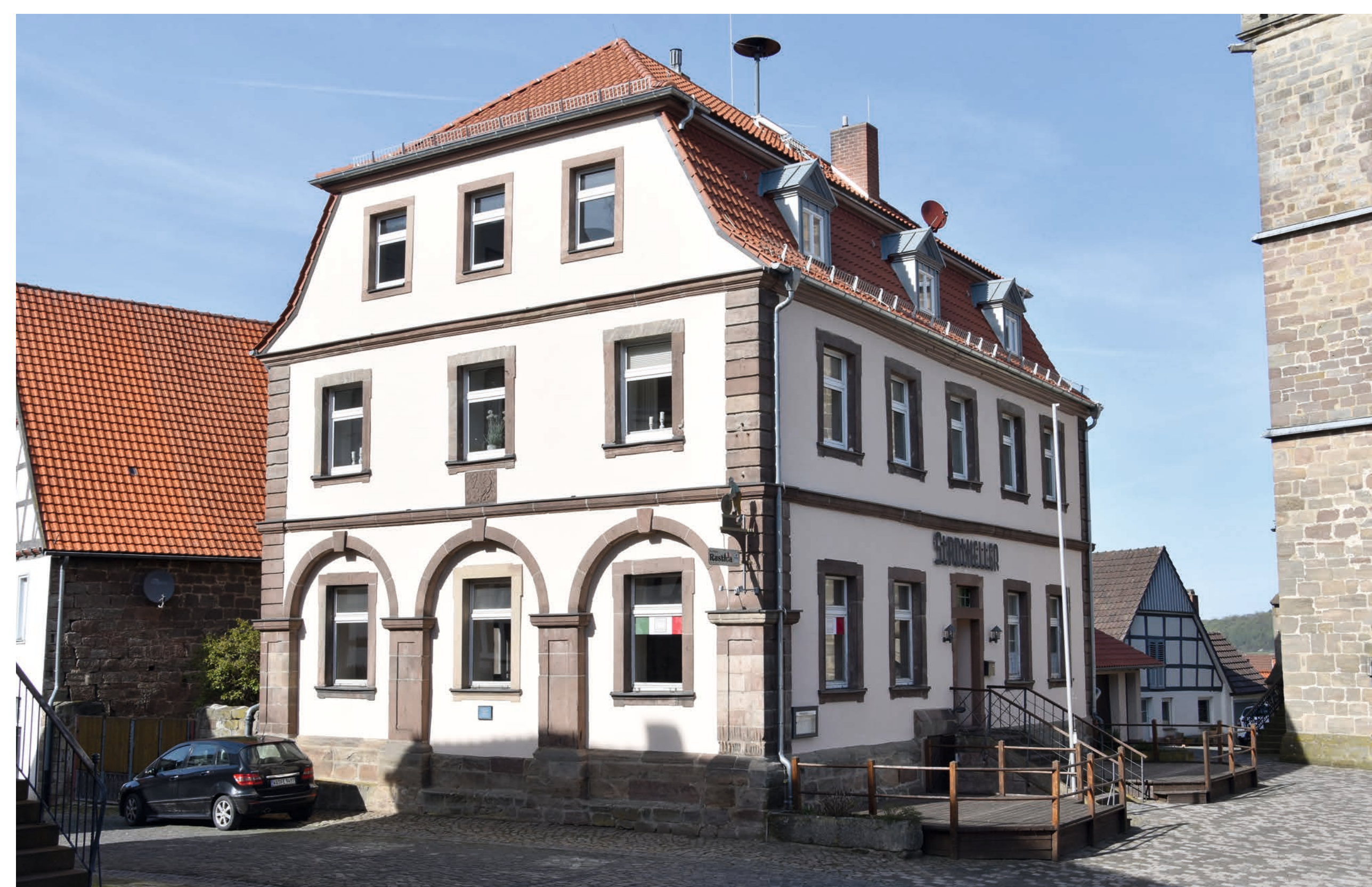
Nach den ersten Sanierungsmaßnahmen.
