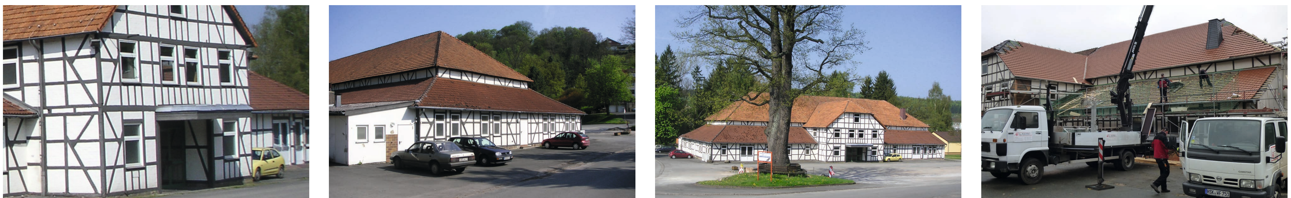
Zustand der Stadthalle vor und während der Umgestaltung.
