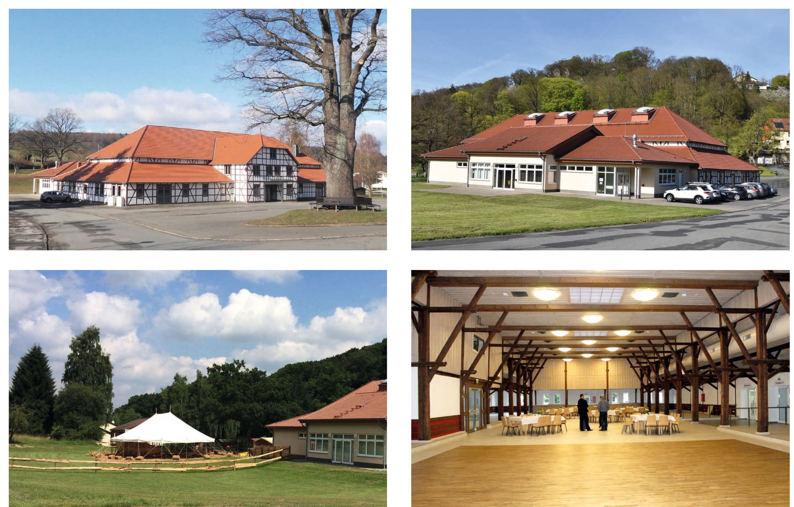
Außenansichten und Blick in den Veranstaltungssaal der sanierten Stadthalle.
