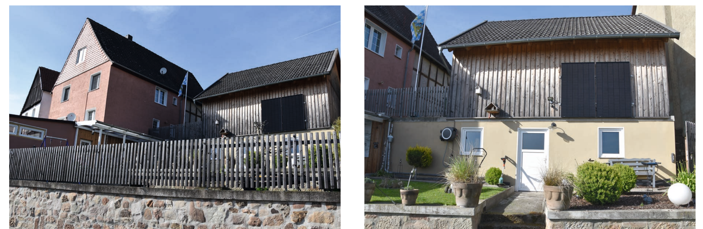
Rückbau eines Gebäude und Ersatzneubau einer Garagenanlage, Sanierung der Stützmauern und Anlage eines Gartens.
