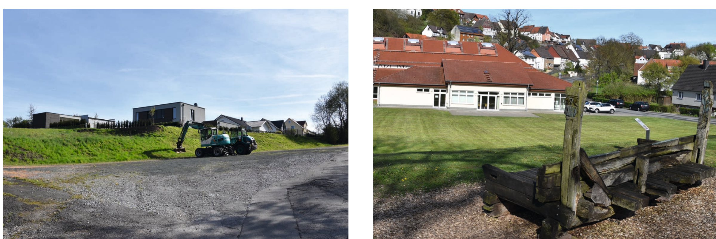
Verbauter und zugewucherter Bereich rund um den ehemaligen Bauhof vor dem Rückbau (oben) und nach dem erfolgten Abriss der Gebäude und Gestaltung der umliegenden/gegenüberliegenden Freiflächen (unten). Die Aussichtsbank wurde aus gesicherten Fachwerkbalken der Gebäude im Burggraben gebaut.
