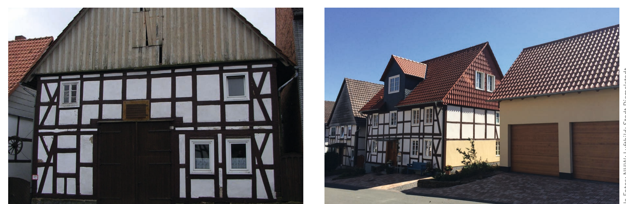
Eine Umnutzung der Scheune war nicht möglich daher erfolgte ein Rückbau.
