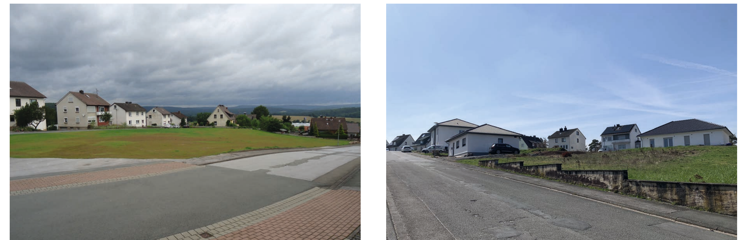
Gelände und Gebäude des ehemaligen Möbellagers vor dem Rückbau (oben), durch den Rückbau entstandene Freifläche (unten links) und bereits erfolgte Neubebauung (unten rechts).
