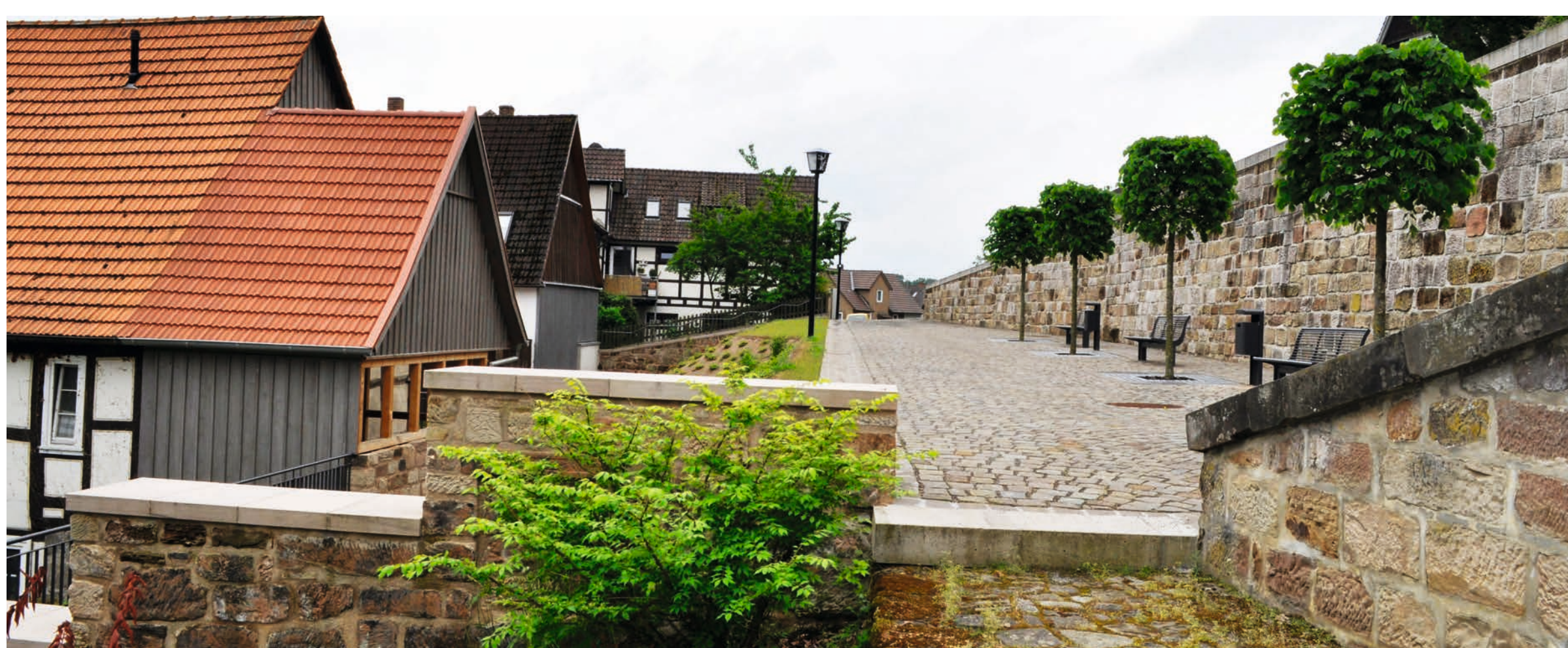
Der Bereich am Burggraben vor dem Rückbau der Gebäude (oben) und nach der anschließenden Umgestaltung der neu entstandenen Freiflächen (Mitte und unten).
