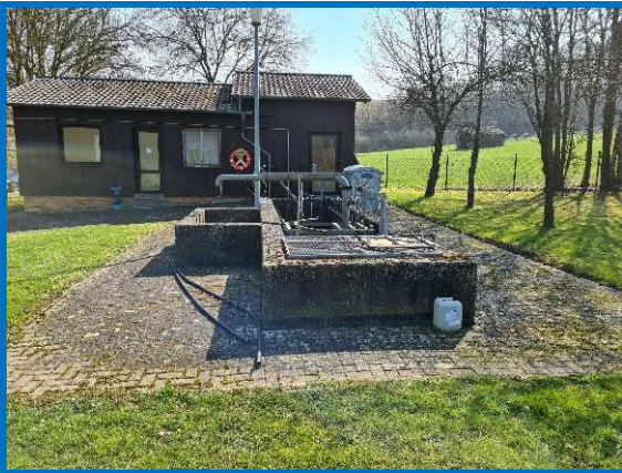
Betriebsgebäude und Sandfang (Foto: GuP)
